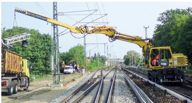
das Zweiwegefahrzeug NICHT verändert, sondern das Sicherheitssystem, gleich einem Anbaugerät, montiert. So verliert der Bagger nicht seine Zulassung
